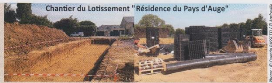
Chantier du Lotissement "Résidence du Pays d'Auge"
