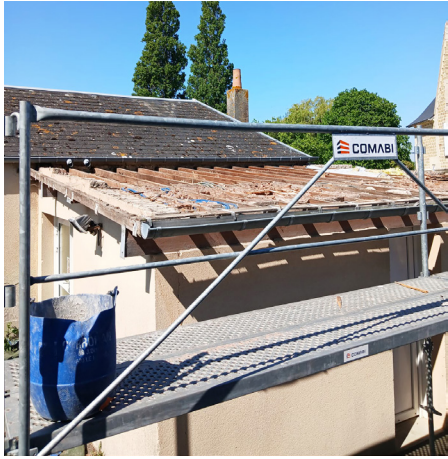
Réfection de la toiture des sanitaires publics
