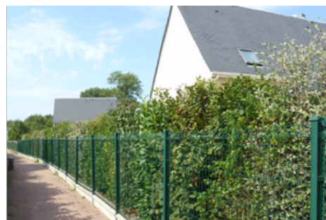
😐 Clôture implantée côté extérieur du lot privé
